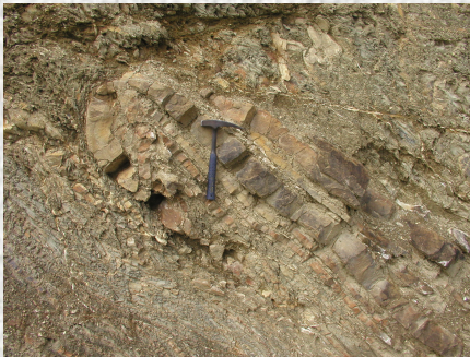
Naslovnica: Borane flišne naslage unutar Čičarijske paleogenske ljuskave strukture u zasjeku građevinskog objekta u selu Hlaji (autor: Damir Palenik)
